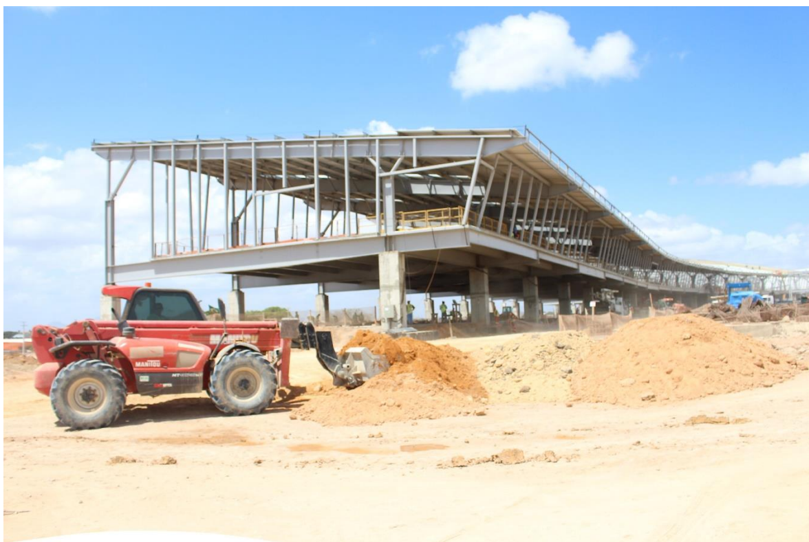
Imagem obras de ampliação.
